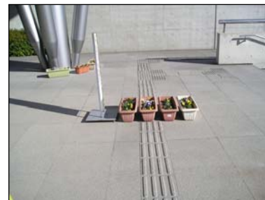
誘導用ブロックの上にプランターが置いてある
