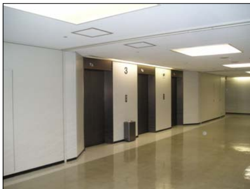
押しボタン前に物が置いてあり、車いすや子供、視覚障がい者が近寄れない
