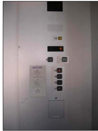
点字は押しボタンの左側に設置するのが望ましい
