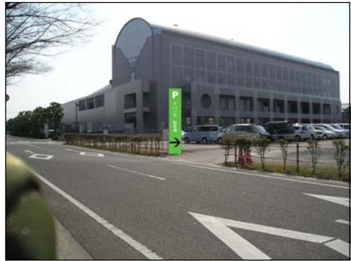
駐車場入口を示すサインを設置する例
