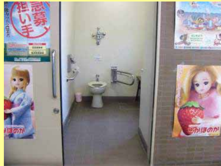
本庁・支所の「車イス対応トイレ」
