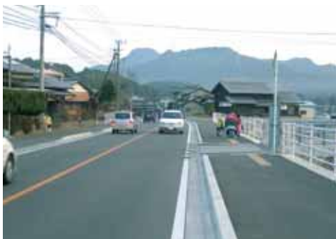
段差を解消した道路整備が進む(県道梅野有田線)
